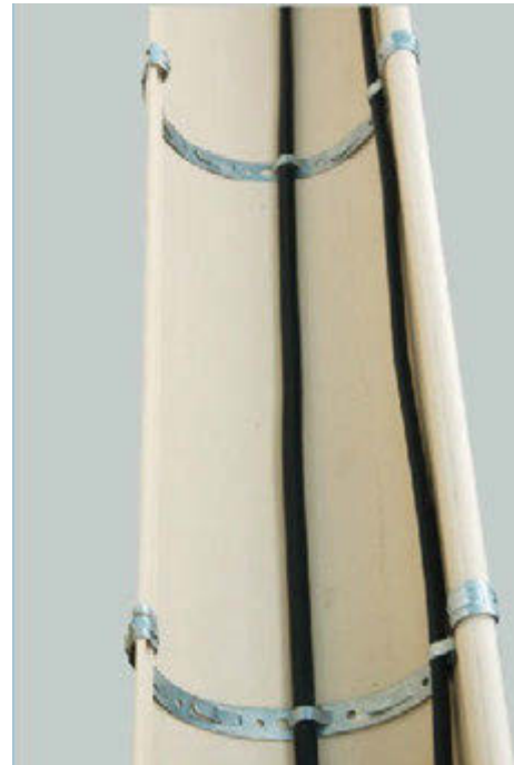
Grejni kabl instaliran u oluk uz pomoć ELEKTRA TMS trake
