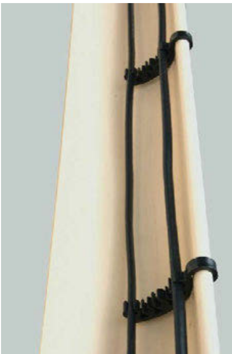
Grejni kabl instaliran u oluk uz pomoć plastičnih držača
